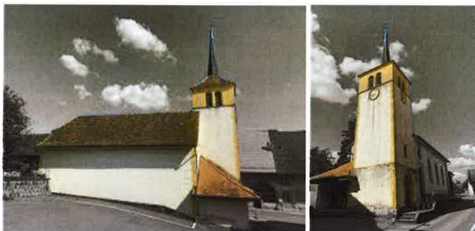
Réfection du clocher et de la façades Nord-Ouest de la nef.
